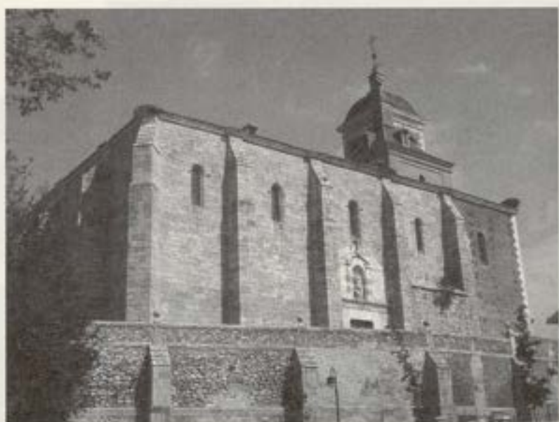
Foto 7. Exterior de la Iglesia de Nuestra Señora de la Asunción donde se aprecian las diferentes etapas constructivas. Meco (Madrid).
