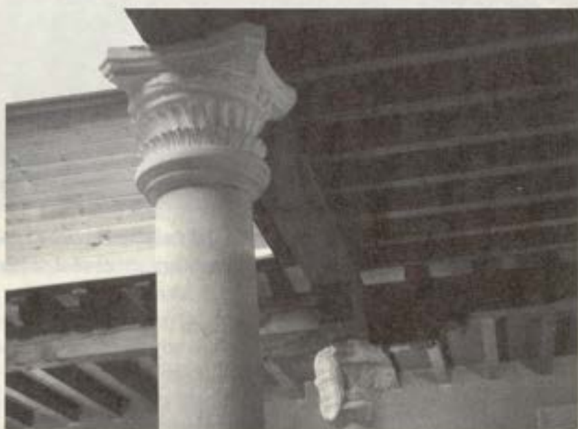
Foto 3. Palacio Dávalos. Columnas del patio con capiteles alcarreños y remate de escudos tallados en los ángulos.
