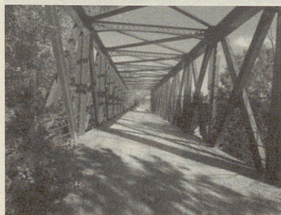
(Fig. 9. El puente de hierro del soto de Aldovea en nuestros días, tras el proceso de limpieza y pintura de paramentos superiores realizado en 2013).
