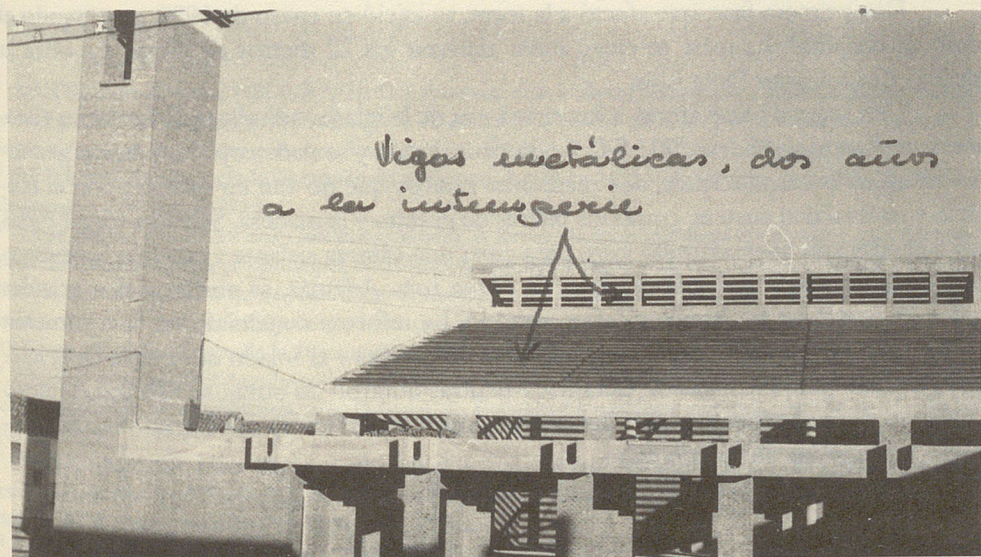
Obras de Construcción de la Iglesia en 1970 37
