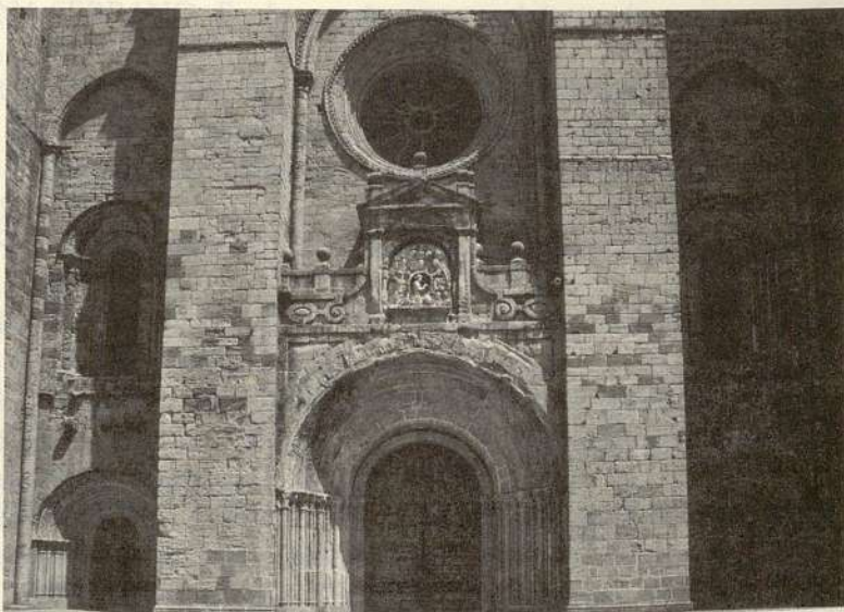
Fig. 2. Fachada occidental de la catedral de Sigüenza, c. 1200. Foto autor.
