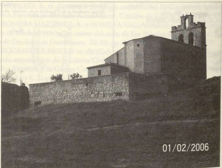
Gran refugio de hormigón recubierto de sillarejo en Cerezo de Moherndo.
