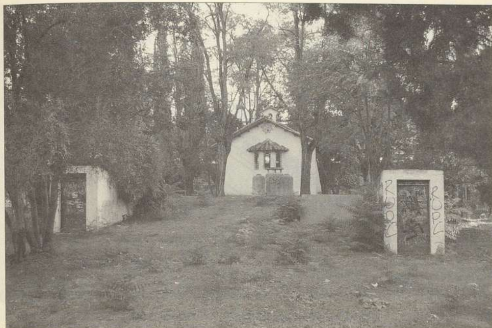
Refugio en el aeródromo Barberán y Collar, en el actual Campus de la Universidad de Alcalá. Se ven las dos entradas, los respiraderos y al fondo, la capilla.
