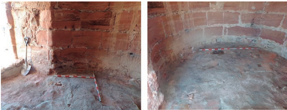
Figuras 7 y 8.- Detalle de los trabajos en interior y enlosado original.
