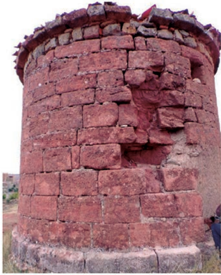
Figura 3.- Pared con las huellas del grupo A1.
