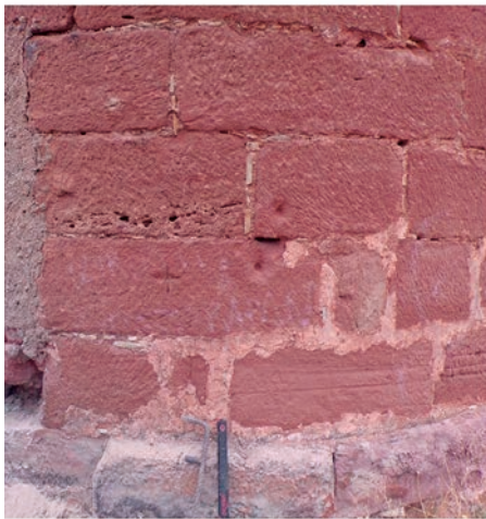
Figura 4.- Pared con las huellas del grupo A2.
