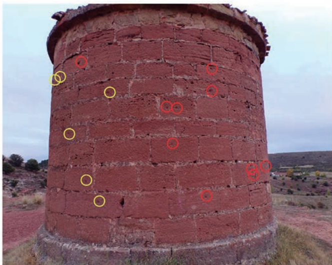
Figura 5.- Ubicación de la huella de disparos en la cara norte.: izqda. grupo A3, dcha. grupo A4.
