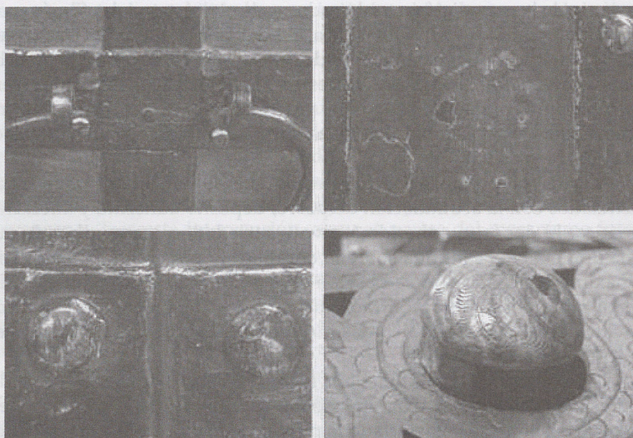
Figura 7. Varias patologías encontradas.
