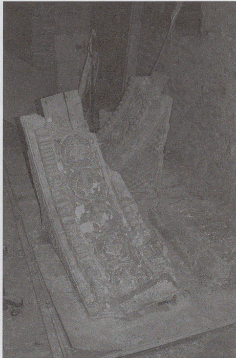
Figura 11. Estado del arco tras su retirada de la ermita del Cristo de los Doctrinos.
