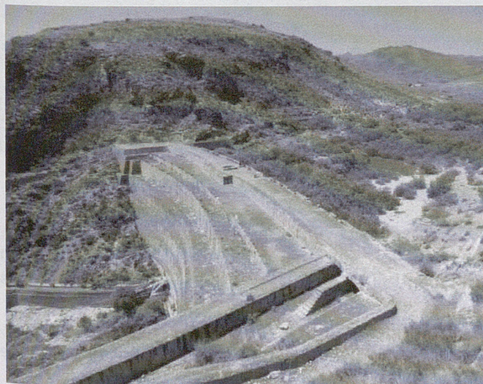
Figura 21. Embalse de Isabel II, en Almería, completamente inutilizado por acumulación de sedimentos. Atlas de Historia económica de Andalucía. SS. XIX y XX. Infraestructuras: Presas y Embalses. Figura 8, 1.
