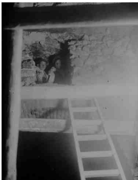
Figura 5: Relleno entre el techo y la bóveda en el túnel nº 2 (A.G.A.)
