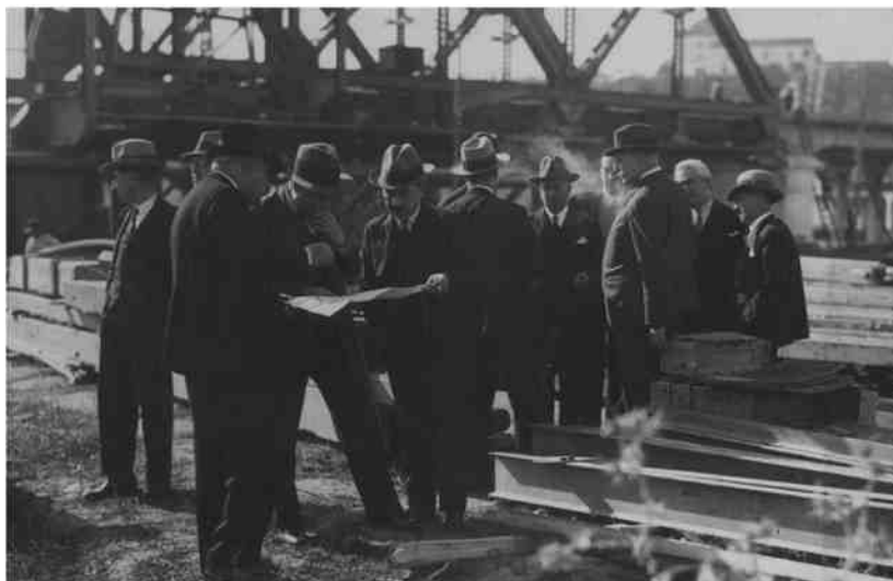
Figura 6: José Salmerón visitando las obras en el puerto de Sevilla, 1932 (A.G.A.)
