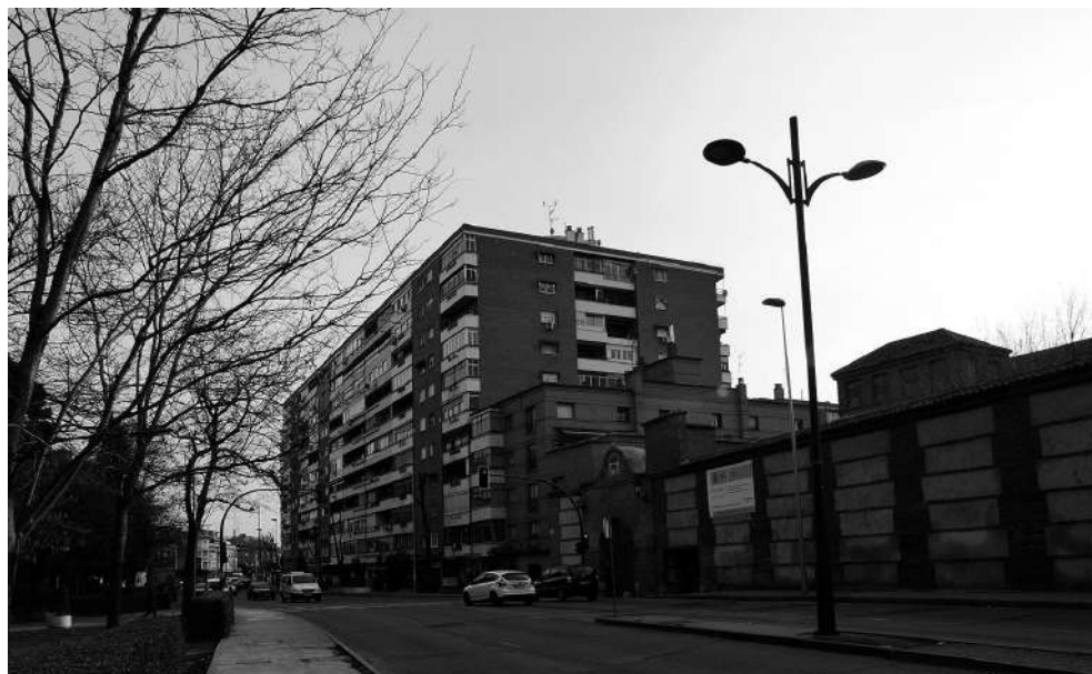
Fotografía 14. Vista actual de los edificios conflictivos en Vía Complutense. Autor Baldomero Perdigón Melón
