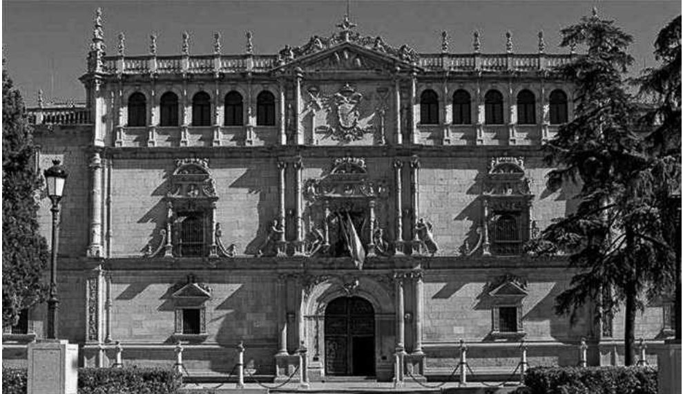
Figura 1. Fachada de la Universidad de Alcalá
