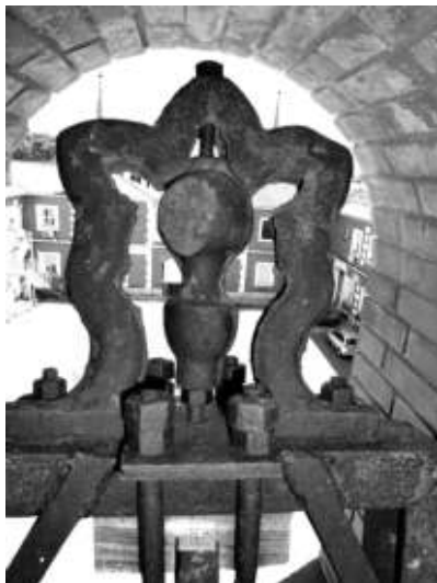
Detalle del yugo y pieza de volteo. Foto: Ambrosio Sánchez de Ribera Pecci.
